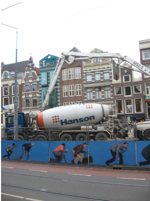
Het beton wordt gestort. Foto Guus Lindeman.
